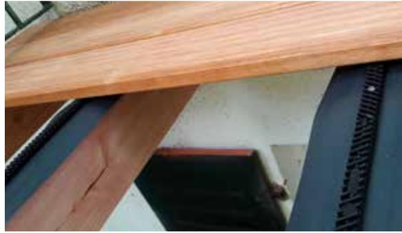
... die beidseitig mindestens 20 mm übersteht. Dadurch läuft das Oberflächenwasser seitlich ab. Eine auf der Folie montierte Distanzleiste sorgt für Abstand zwischen den Brettern und der Tragkonstruktion
