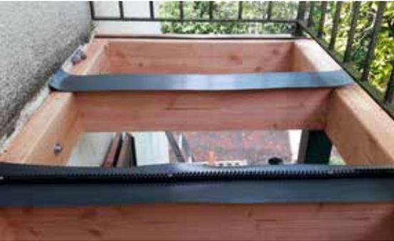
Um Staunässe zwischen Brettern und Tragkonstruktion zu vermeiden, platzierte man Hartholzstreifen mittig auf den Balken. Darüber wurde eine Z-Folie verlegt ...
