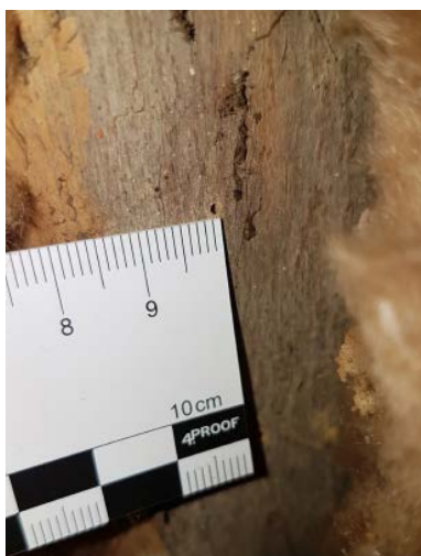
► Runde Ausschluflöcher mit einem Durchmesser von 1 bis 2 mm
